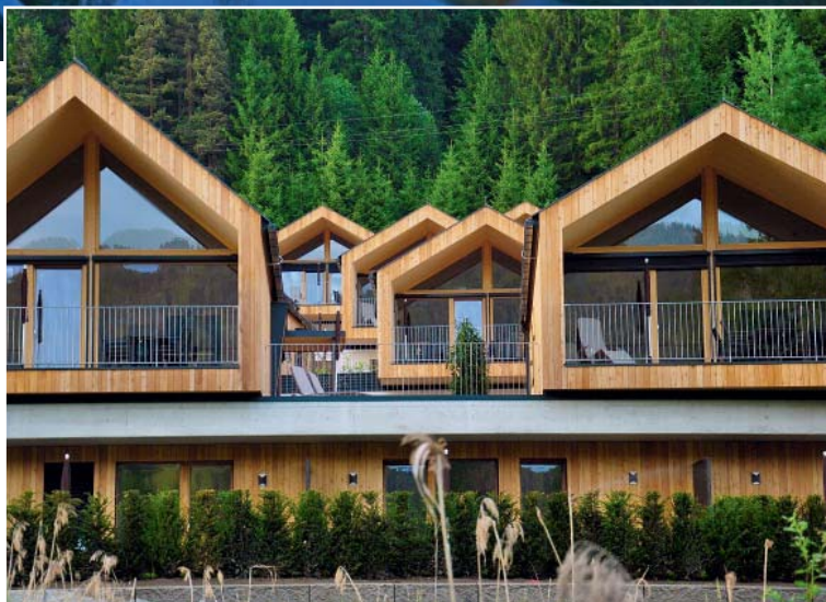
Direkt am See liegt das neue Saunahaus. Auf der Leiten darüber reißen sich die neuen Appartements
